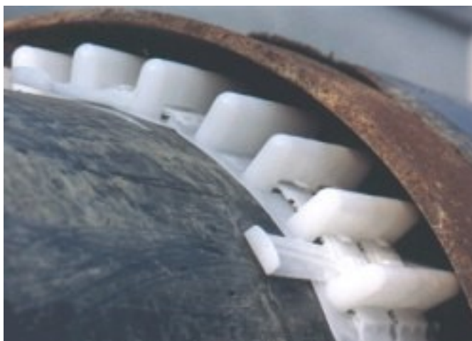
Figura 6-21 – collari distanziatori in HDPE
