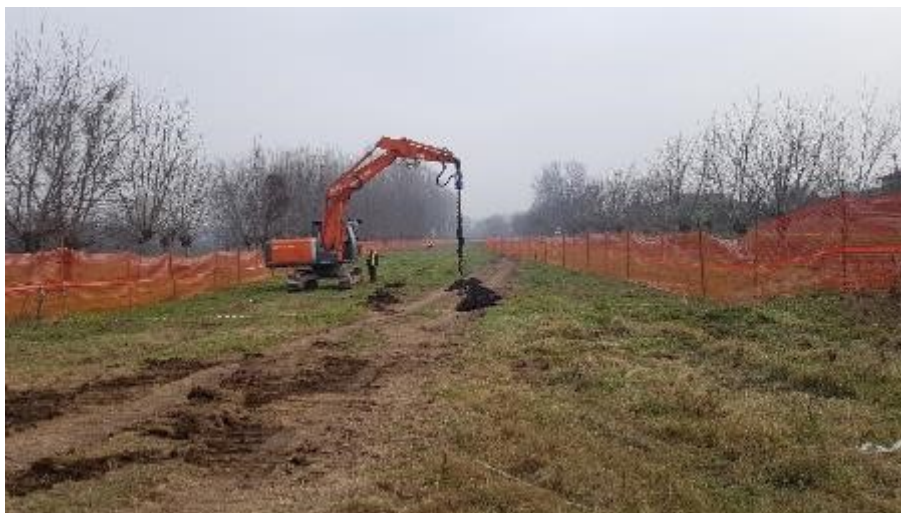
Figura 6-1 – Esempio di bonifica bellica lungo il tracciato
