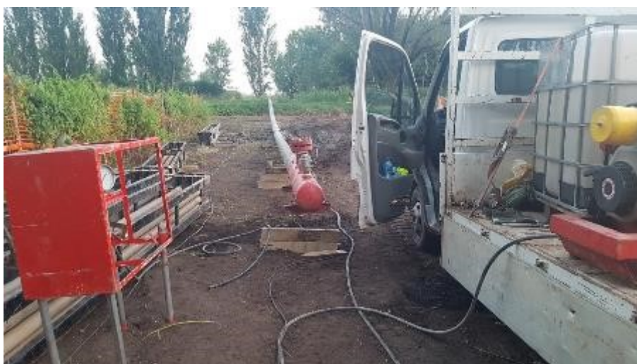
Figura 6-31 – Collaudo idraulico
