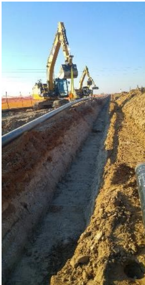
Figura 6-14 – Esempio di posa con escavatori
