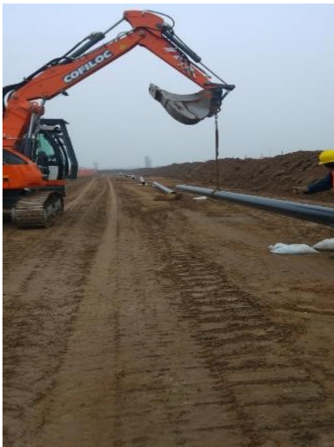
Figura 6-8 – Esempio di sfilamento dei tubi
