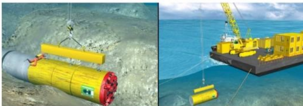
Figura 6-36 – Recupero della fresa meccanica a mare
