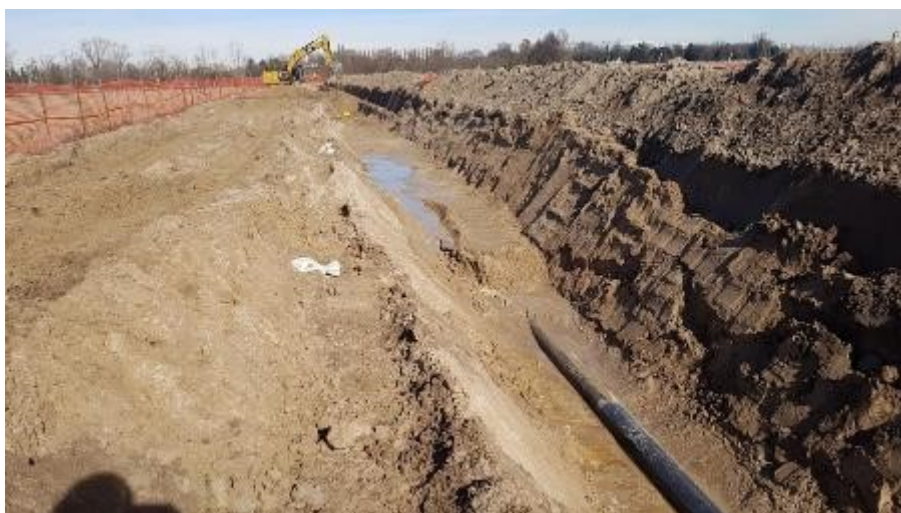
Figura 6-17 – Rinterro della condotta
