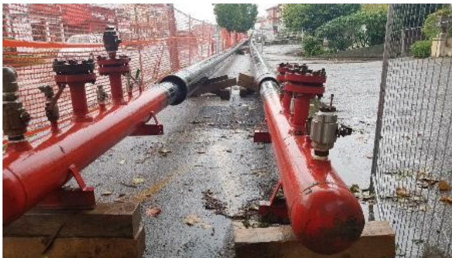
Figura 6-30 – Collaudo idraulico, piatti di prova
