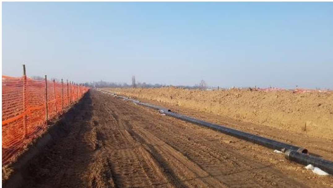
Figura 6-9 – Sfilamento dei tubi lungo la pista di lavoro
