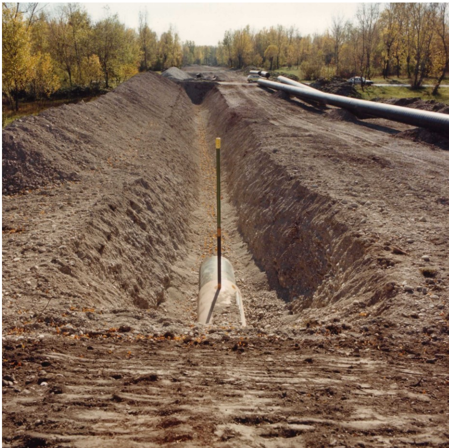
Figura 6-18 – Attraversamento con tubo di protezione, dettaglio dello sfiato
