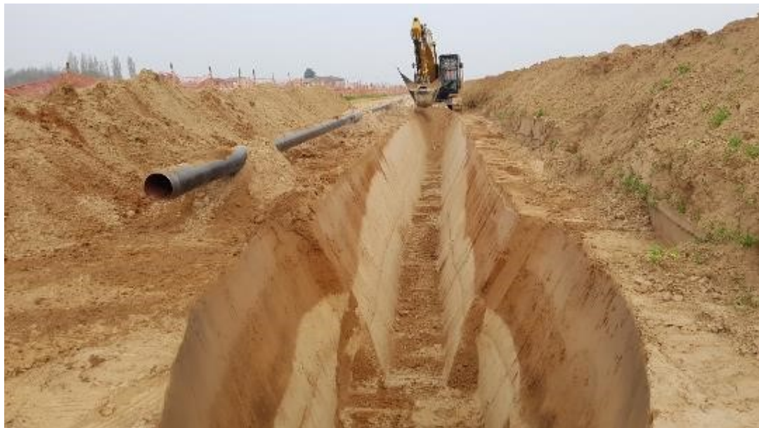
Figura 6-10 – Esempio di scavo di una trincea con terreni sciolti
