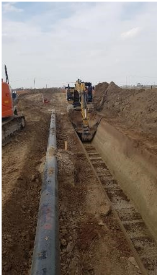
Figura 6-11b – Scavo della trincea con escavatore
