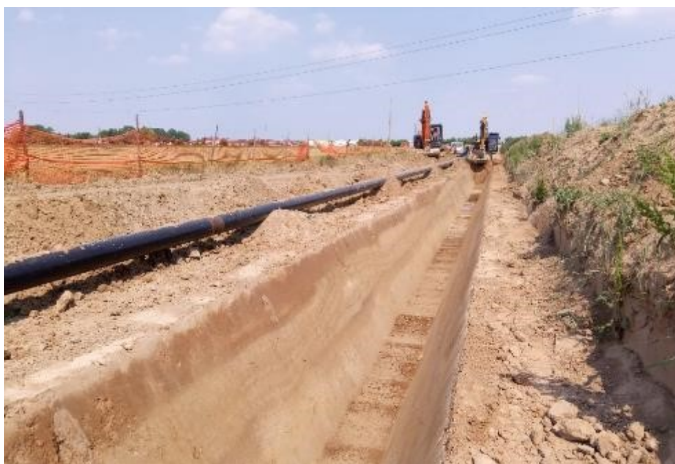
Figura 6-11 – Scavo della trincea con tubazioni saldate lungo la pista lavoro
