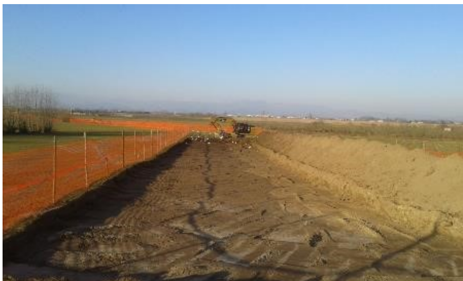
Figura 6.2 – Esempio di pista di lavoro
